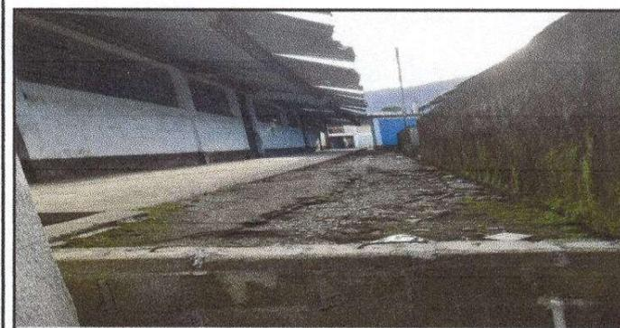
Foto 5: Instalación de piso de torta de concreto de 5 cm de grosor, por encharcamiento.
